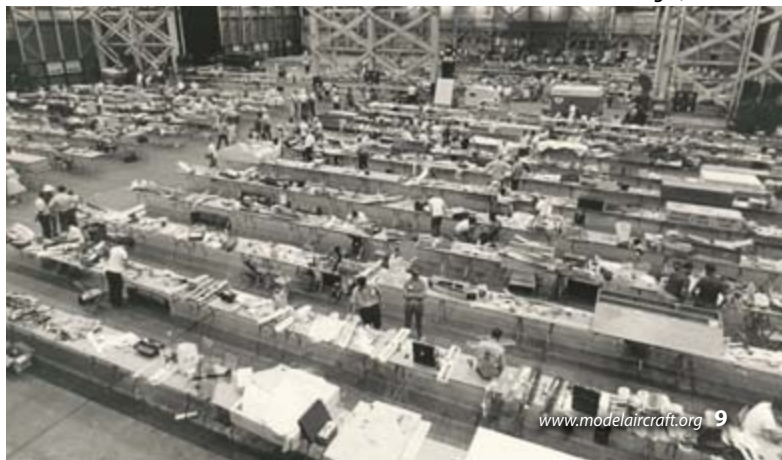
Nats Construction Hangar, 1969
